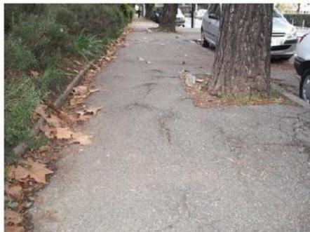
*Racines ayant déformé la planéité de la surface et pouvant former des entraves (difficilement décelables pour les PAM)
