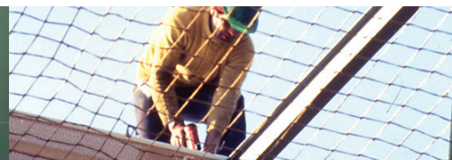
3 Filets de recueil
