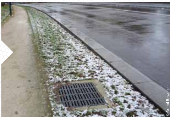
Besançon a déconnecté 78 500 m 3 d'eau de pluie lors du réaménagement d'une route.
