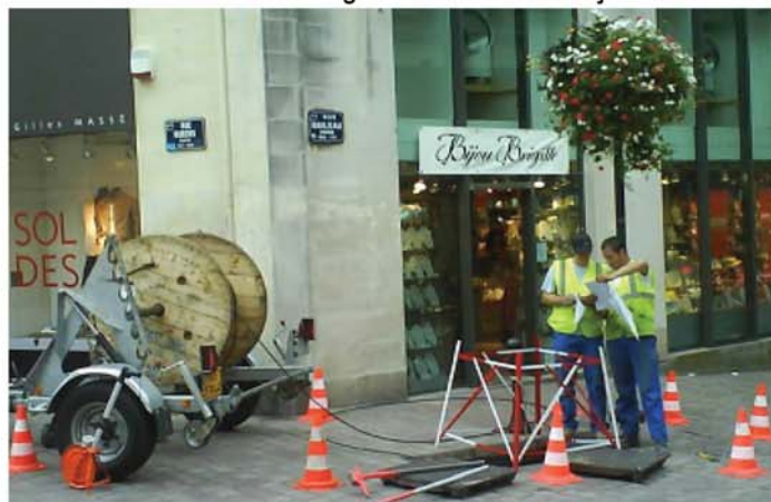
Fibrage d'une rue commerçante à Nantes
