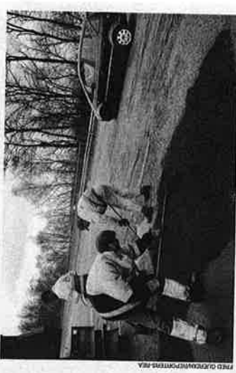
CI-dessus: vieillissantes, les chaussées ont vu de nombreux nids-de-poule apparaître à leur surface l'hiver dernier. Un phénomène accentué par la multiplication des cycles gel/dégel. CI-dessous: pendant l'hiver, les services techniques rebouchent en urgence les nids-de-poule, créant des «rustines» en enrobés à froid d'une faible durée de vie.
