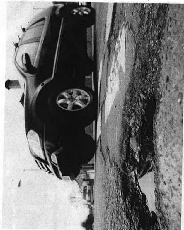
CI-dessus: vieillissantes, les chaussées ont vu de nombreux nids-de-poule apparaître à leur surface l'hiver dernier. Un phénomène accentué par la multiplication des cycles gel/dégel. CI-dessous: pendant l'hiver, les services techniques rebouchent en urgence les nids-de-poule, créant des «rustines» en enrobés à froid d'une faible durée de vie.
